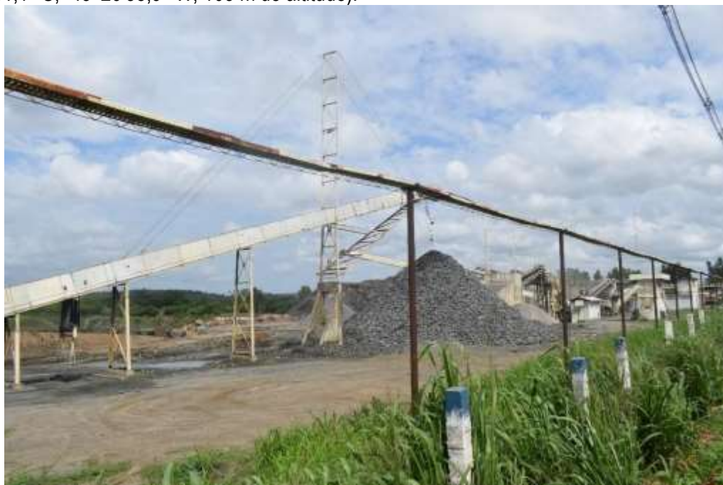
Figura 192 – Mineração na MA-034, entre Caxias e Buriti Bravo - MA (Coordenadas geográficas: - 05°13'41,1" S; -43°26'58,9" W; 103 m de altitude).
